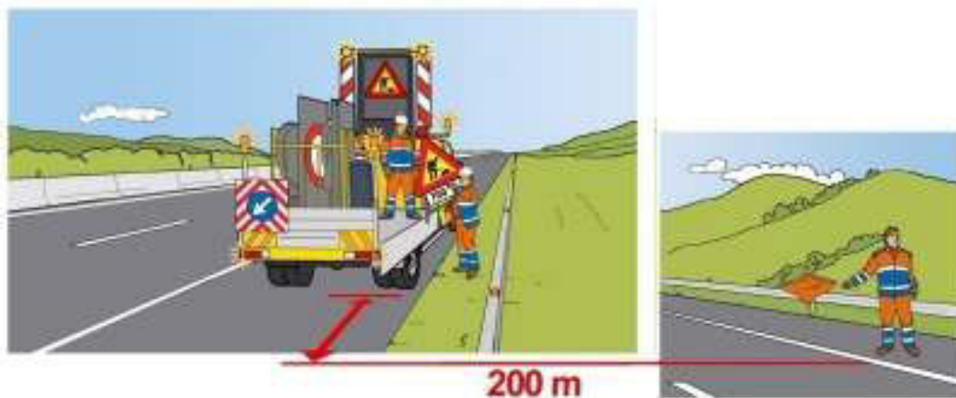
Figura 34 – Chiusura della corsia di sorpasso: scarico ed installazione del segnale lavori sul margine destro
