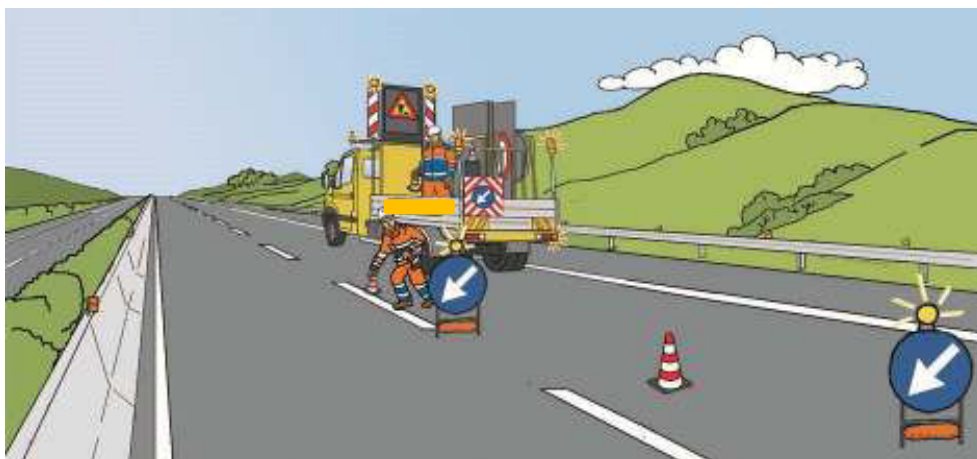
Figura 31 – Chiusura della corsia di marcia: inizio della posa dei coni
