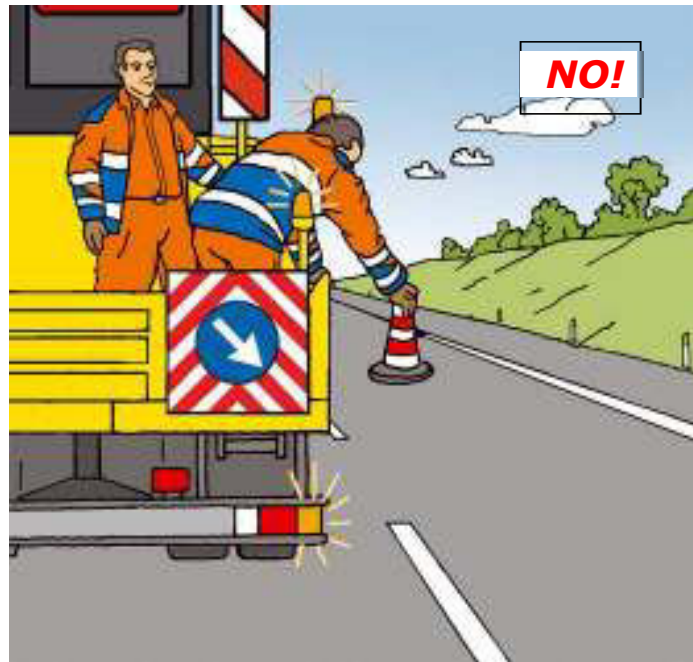
Figura 58 – Posizionamento dei coni o defleco: comportamento scorretto
