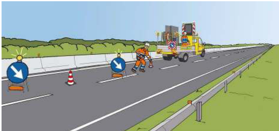
Figura 55 – Chiusura della corsia di sorpasso: inizio della posa dei coni
