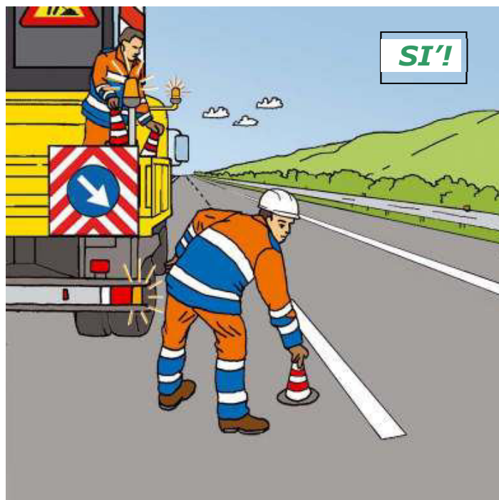
Figura 57 – Posizionamento dei coni o defleco: comportamento corretto
