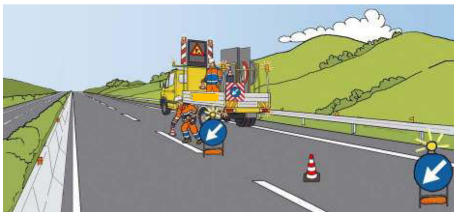
Figura 48 – Chiusura della corsia di marcia: inizio della posa dei coni
