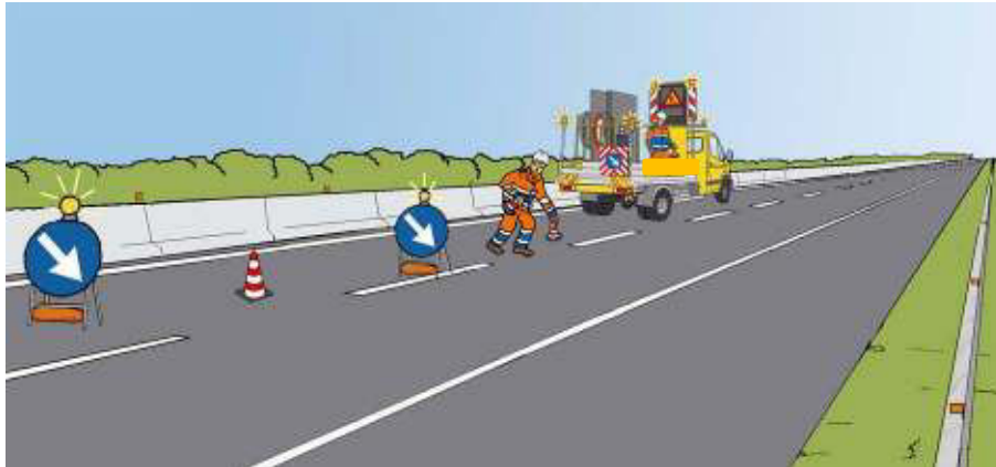
Figura 41 – Chiusura della corsia di sorpasso: inizio della posa dei coni
